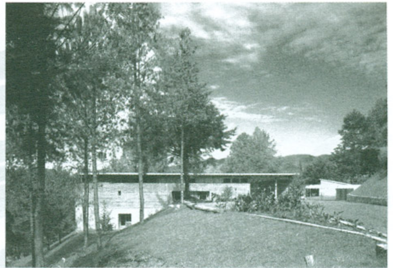
Casa Posada, El Retiro, 1995 Alejandro Echeverri, Juan Bernardo Echeverri Arquitecto colaborador: Luis Fernando Morales
