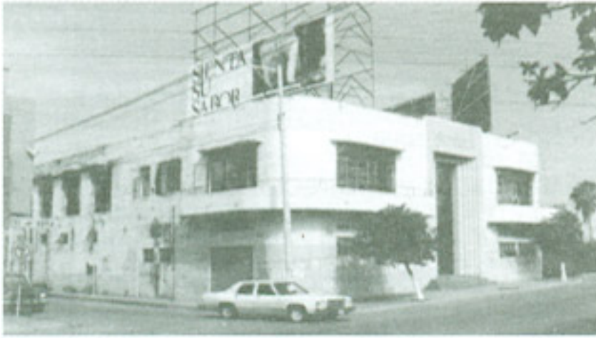
Casino Culiacán (antes) Proyecto de Constantino Haza
