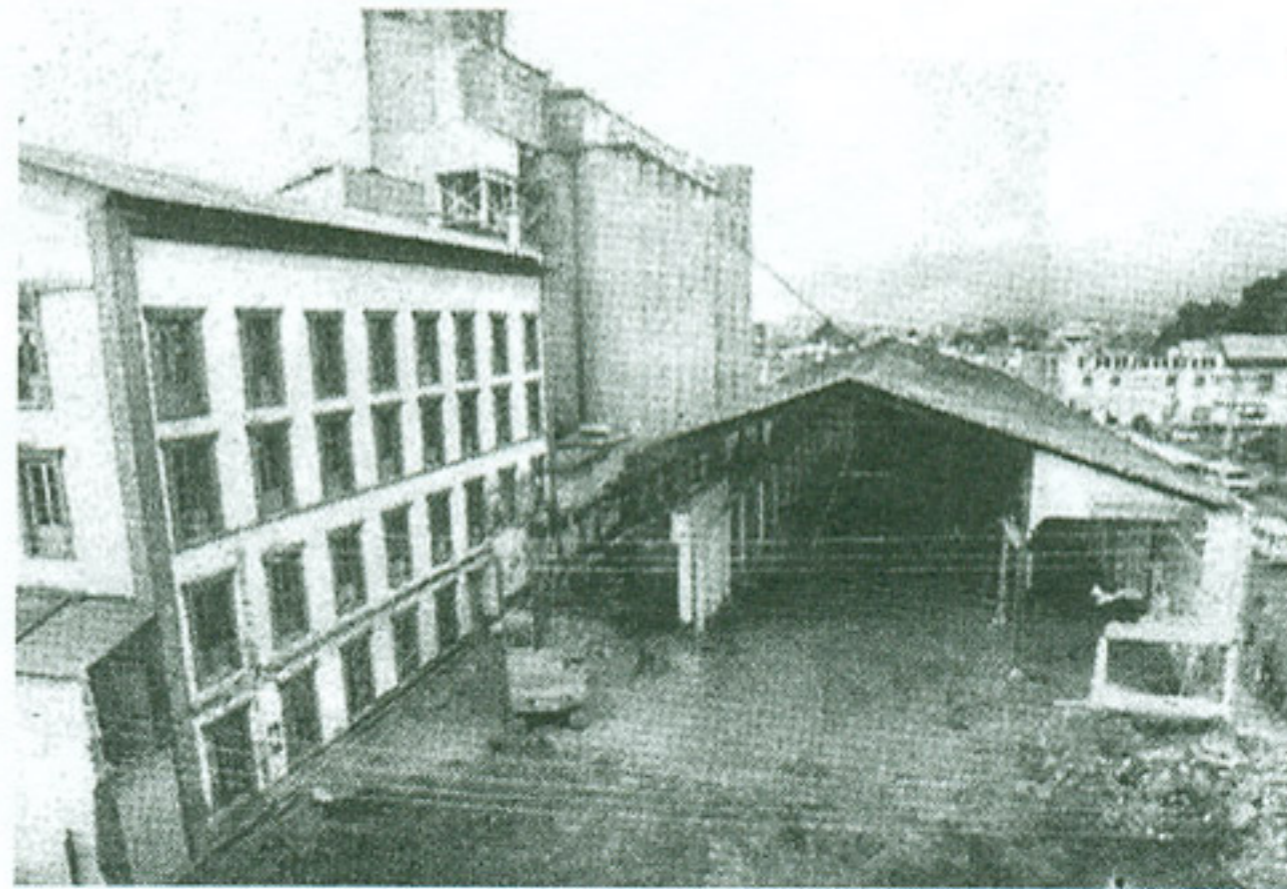
Demolición parcial del histórico edificio en Amecameca donde se proyecta otro Wal-Mart.
