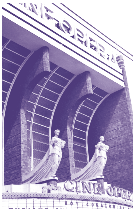
Cine Ópera con su fachada monumental, en la colonia San Rafael. Actualmente en el abandono. Fotografía: Fototeca INAH Pachuca.
