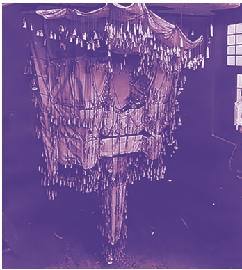
Figura 5. Antonio Gaudí. Modelo físico de la Capilla de la Colonia Güell en Barcelona Tomada de: www.goo.gl/k8XR0l
