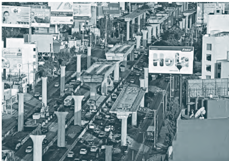
Periférico Sur, Ciudad de México. Columnas que sostienen el segundo piso.
