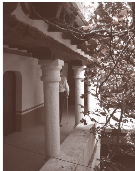
Figura 4: Detalle de zapatas en la iglesia de San Nicolás Oxtotipac, Estado de México Fotografía: Rodrigo Floresvillar Ortiz
