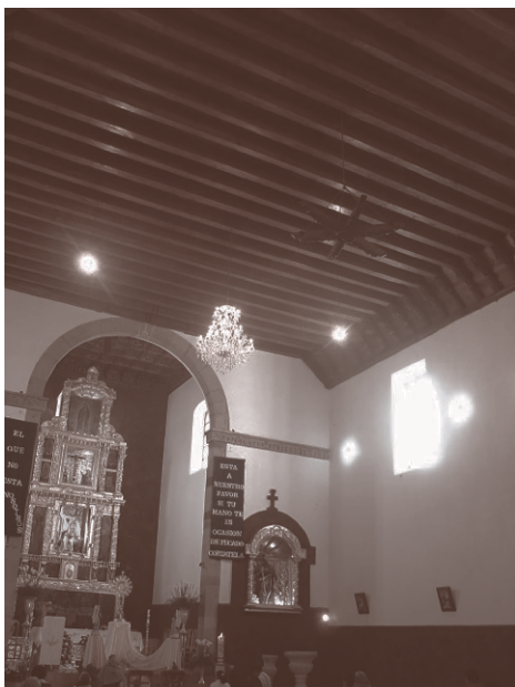
Figura 4: Detalle de zapatas en la iglesia de San Nicolás Oxtotipac, Estado de México Fotografía: Rodrigo Floresvillar Ortiz
