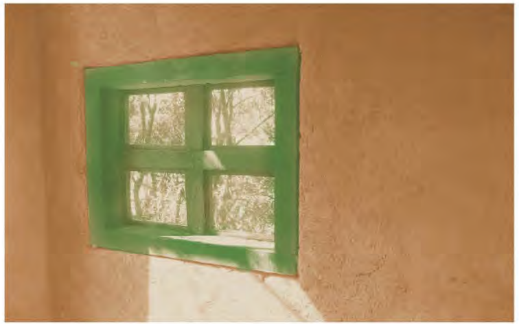
Figura 3. Detalle de muro y ventana en vivienda de tierra (Casa Silvestre Ciudad de México) Fotografía: Andrés Dionisio
