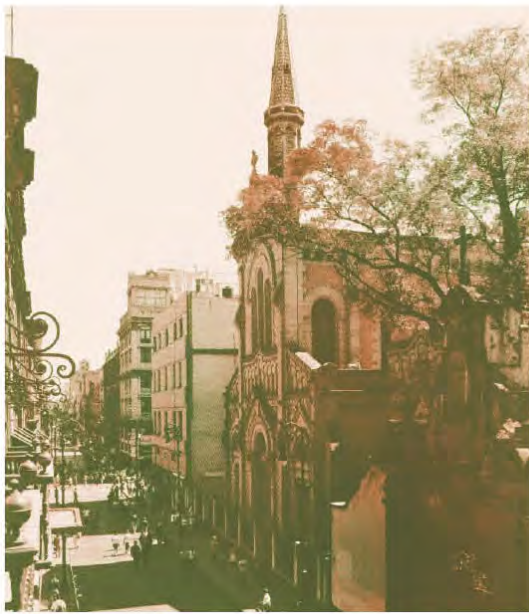
Figura 2: Calle Francisco I. Madero. Entre Eje Central y Gante.
