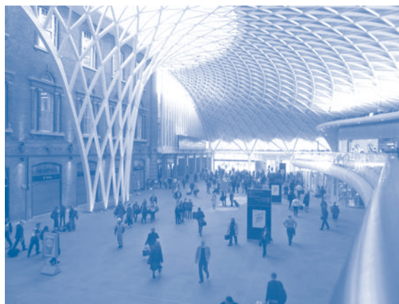
Remodelación de la estación King's Cross
